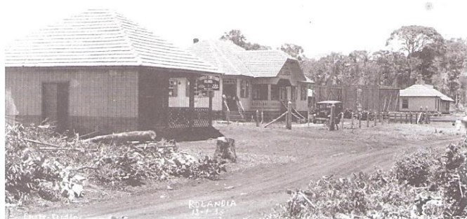
O início de Rolândia deu-se na Av. Getúlio Vargas. Na foto, 1935, vêem-se as primeiras construções: Padaria do Max Dietz, Hotel Rolândia, Hotel Estrela em construção e o escritório da Cia. de Terras.
